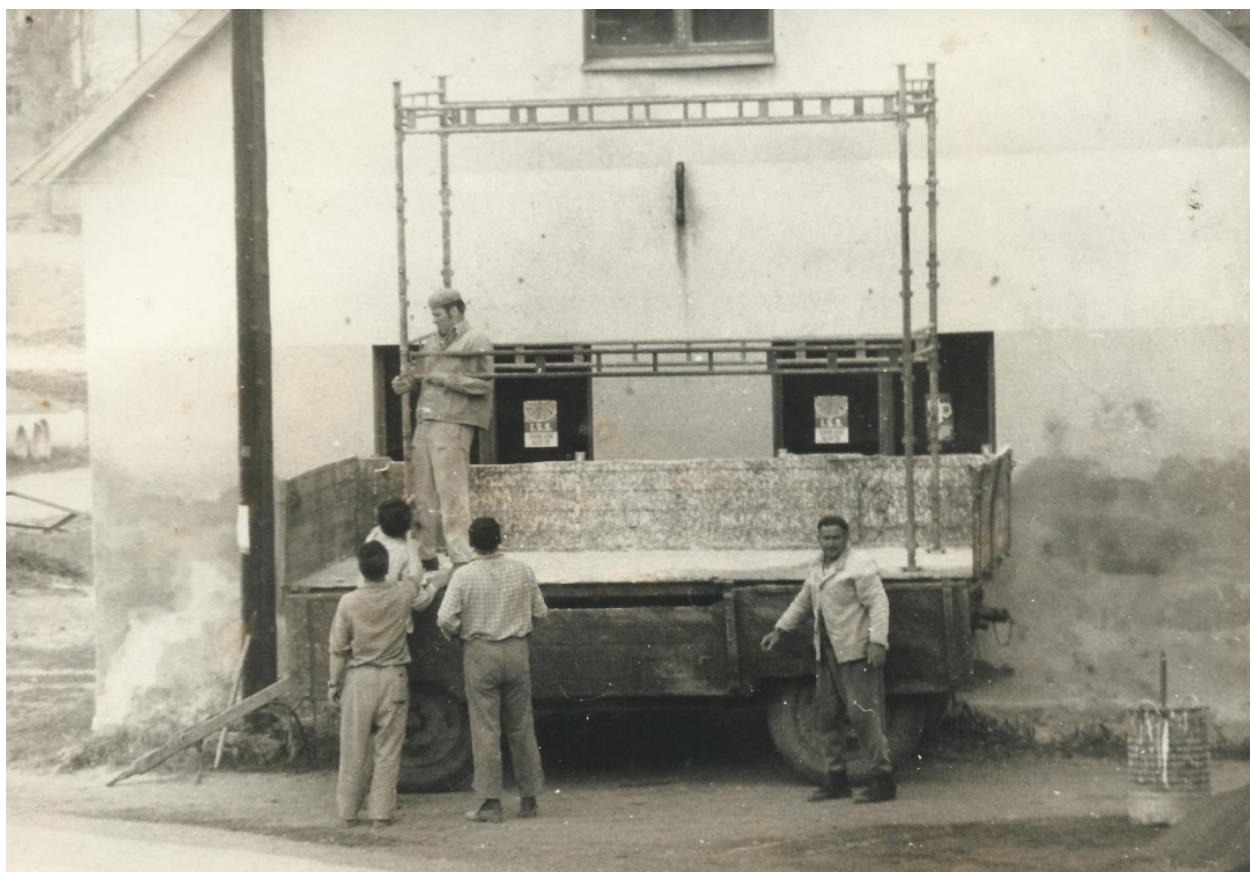
Oprava hasičské zbrojnice
